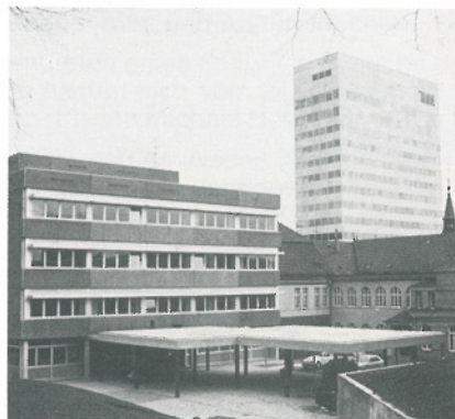
Neue und alte Schule — noch neben- einander (1971)
