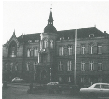
Das alte Schulgebäude (1903 — 1971), kurz vor dem Abbruch
