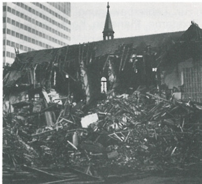
Abriß des alten Schulgebäudes, 1971 — 1972
